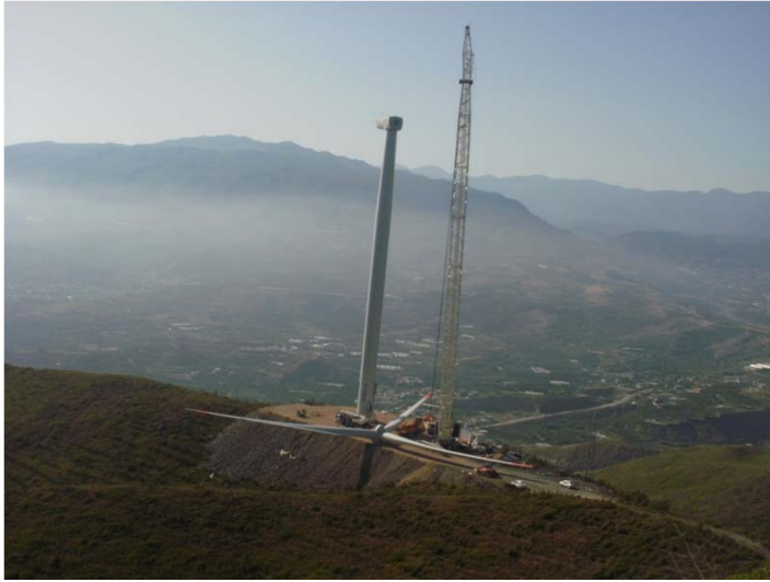
Türbin Yerde Kanat Montajı
