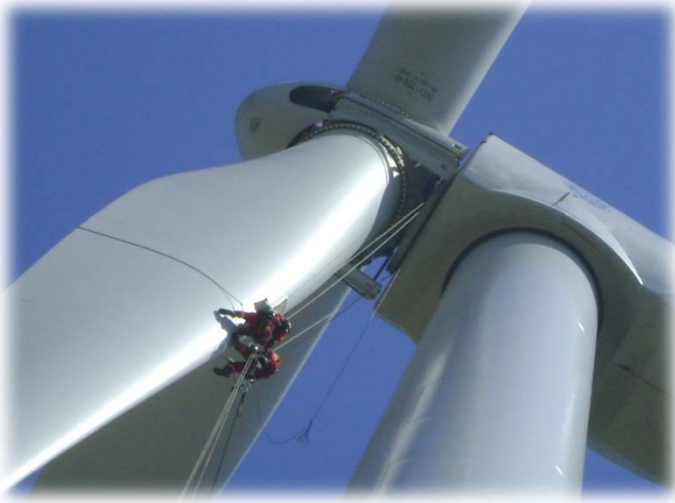
Türbin Kanat Kontrol
