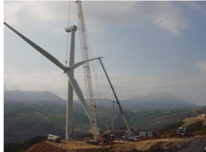
Türbin Rotor Montajı
