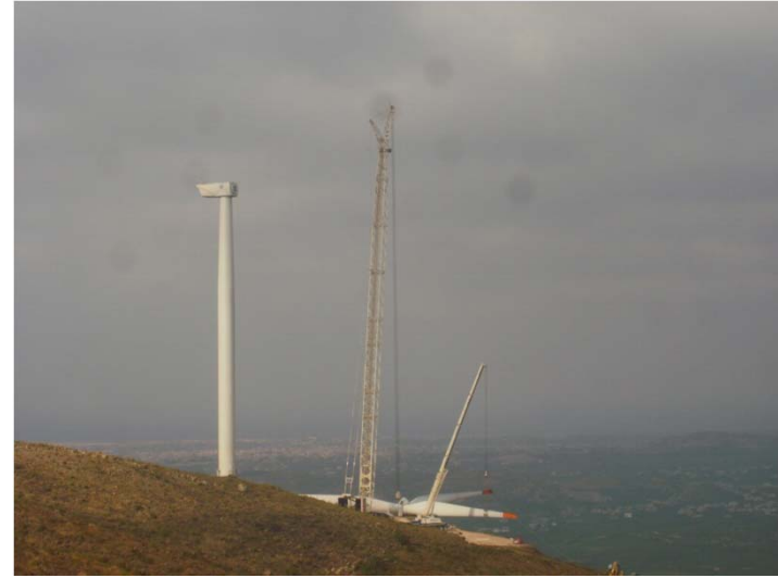
Türbin Rotor Montajı
