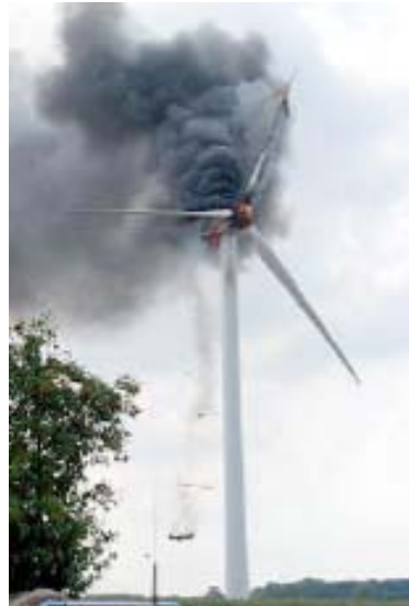
Resim 15. Yıldırım Çarpmış Bir Rüzgâr Türbini
