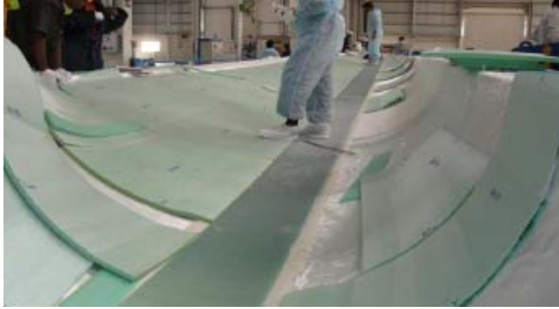
Resim 10. Kanadın Bir Yüzeyinde Köpük Yerleştirme İşlemi
