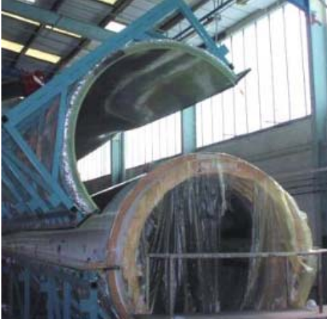
Resim 13. Kanat Kalıbının Sökülmesi
