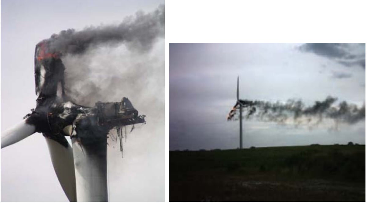
Şekil 3. 2 MW Rüzgar Türbini Yıldırım Çarpması Sonucu Yanıyor
