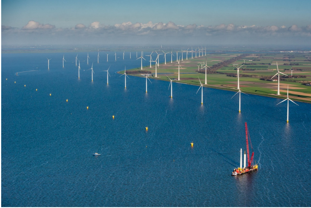
Şekil 9. Westermeerwind rüzgar santraliniin kurulumu [99]
