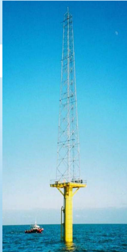
Shell Flat Array DRES Projesi Met Mast
