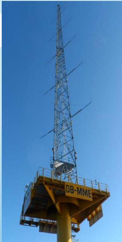
Dogger Bank DRES Projesi Met Mast
