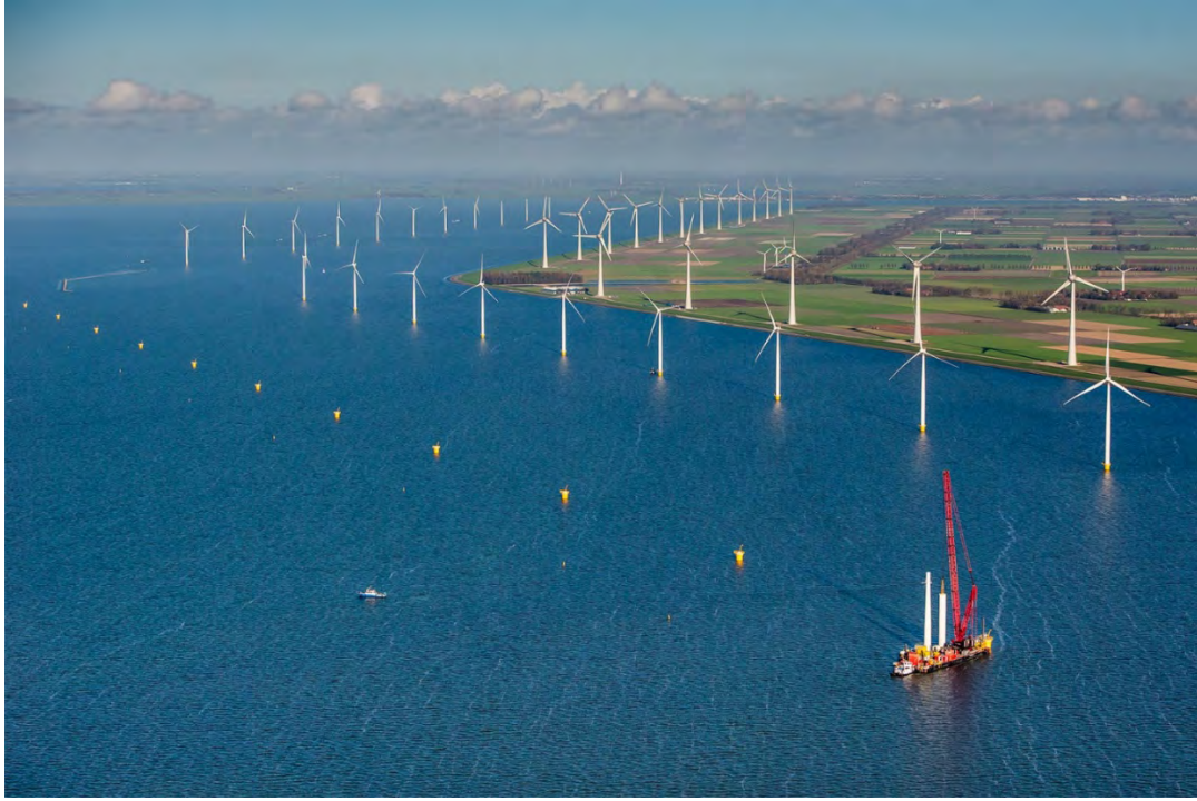
Şekil 9. Westermeerwind rüzgar santraliniin kurulumu [99]
