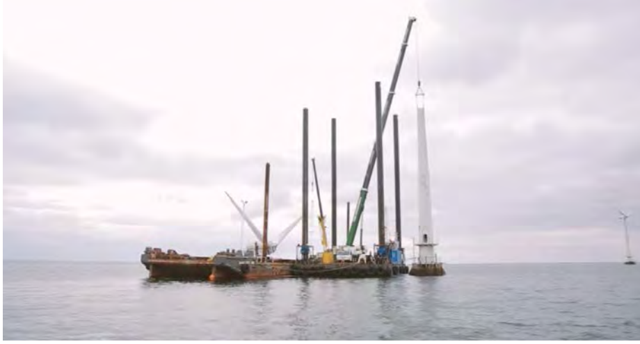
Şekil 5. Dünya'nın ilk açık deniz rüzgar santralini (Vindeby, Danimarka) söküm çalışmaları [26]
