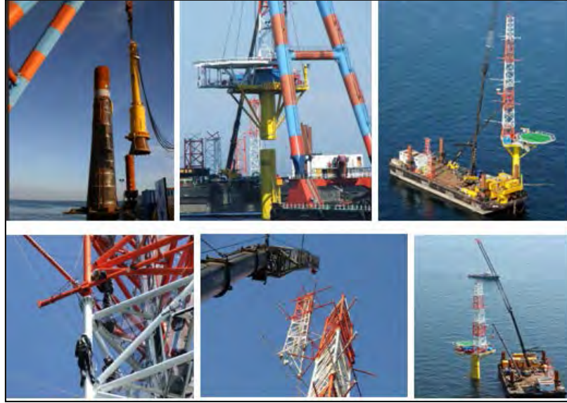
Şekil 6. FINO 3 inşaatına ait fotolar.
