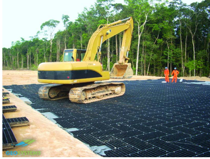
Şekil 5. Geomat ile geçici yol imalatı [Url-4]
