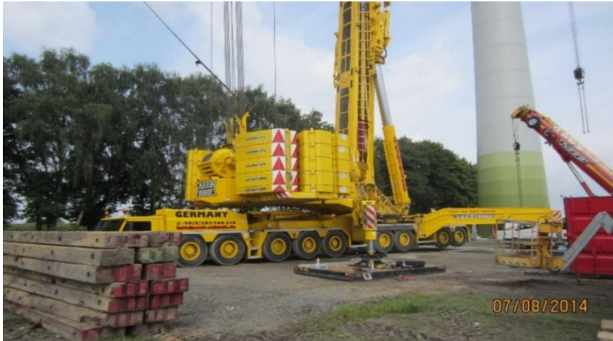
Şekil 6. Geohücre uygulaması ile platform inşaatı [Url-5]
