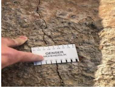
Şekil 18. (a) 1 mm Genişlikli Çatlak (b) Çatlak Uzunluğu Yaklaşık 70 cm
