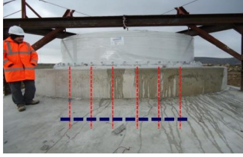
Şekil 6. Adaptör (Hibrit) Bağlantı [6]
