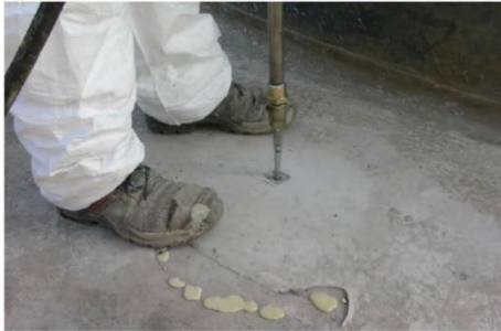
Şekil 22. Kule-Temel Bağlantısı Onarımında Enjeksiyon İşlemi [12]
