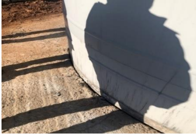
Şekil 17. Kule- Temel Bağlantı Noktasında Ayrışma
