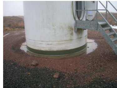
Şekil 9. Gömülü halka bağlantılı rüzgar türbini [2]
