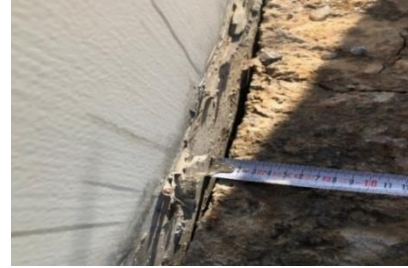
Şekil 17. Kule- Temel Bağlantı Noktasında Ayrışma
