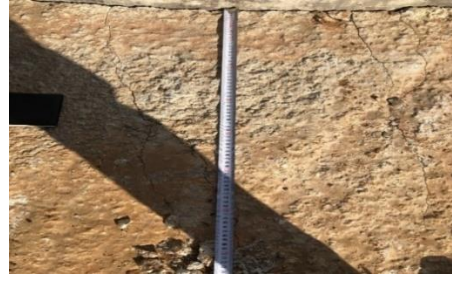
Şekil 18. (a) 1 mm Genişlikli Çatlak (b) Çatlak Uzunluğu Yaklaşık 70 cm
