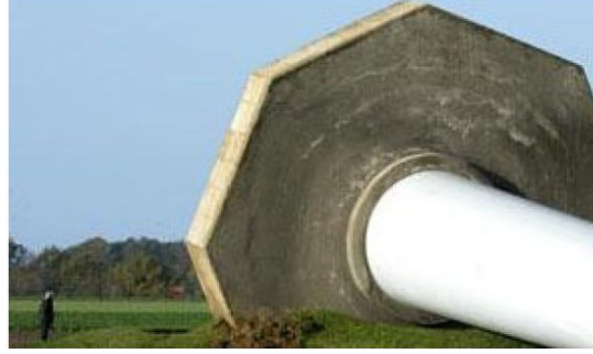
Şekil 1. Goldenstedt Rüzgar Türbininin Göçmesi [2]
